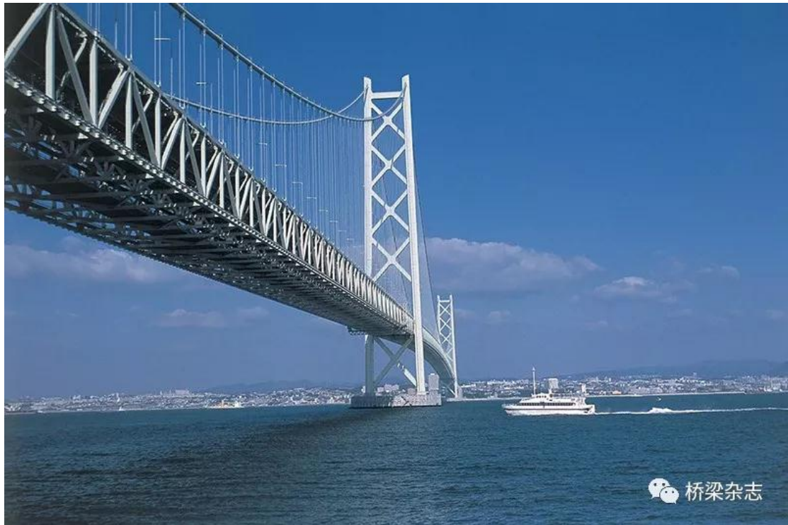
日本明石海峡悬索桥
